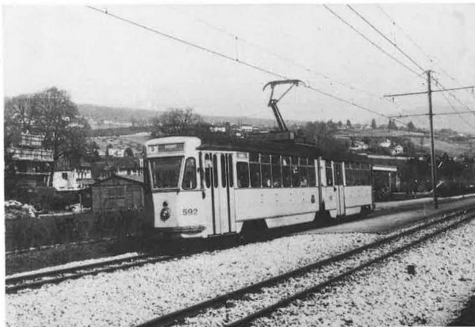
La ligne aérienne d'alimentation, à suspension caténaire, est constituée d'un fil de contact de 107 mm<sup>2</sup> et d'un feeder de 90 à 150 mm<sup>2</sup>. A l'exception de l'antenne de Cortailod à ligne de type tramway sur poteaux en bois, l'ensemble de l'axe Neuchâtel-Boudry est désormais pourvu de poutrelles métalliques modernes.
